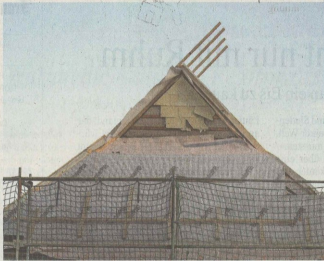
Neues Dach: Vertrauen ist gut, Kontrolle ist besser.
